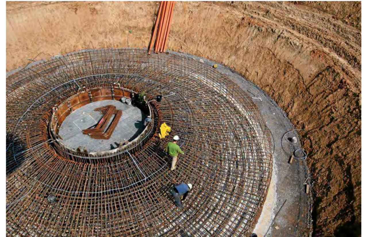
Photographie 2. Maillage dense de ferrailage d'une fondation
